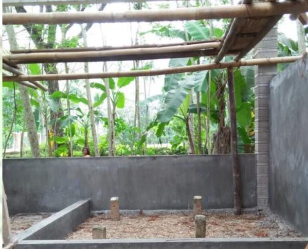
(Gambar Makam yang masih dalam proses pembangunan)
