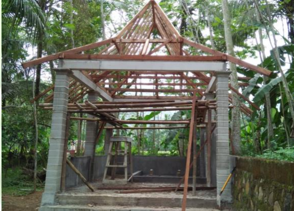
(Gambar Makam saat proses pembangunan)
