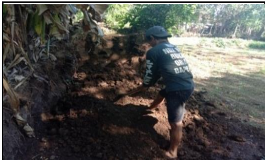
Penggalian tanah sebelum proses diberi air (Foto diambil di lokasi pertama)
